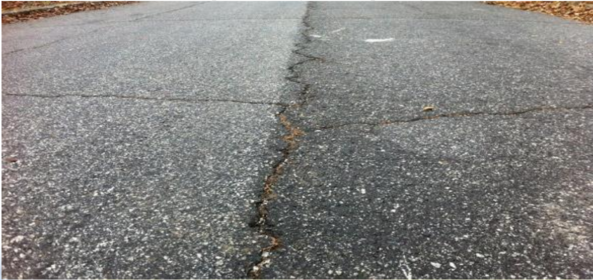
Longitudinal(Linear)Cracking
