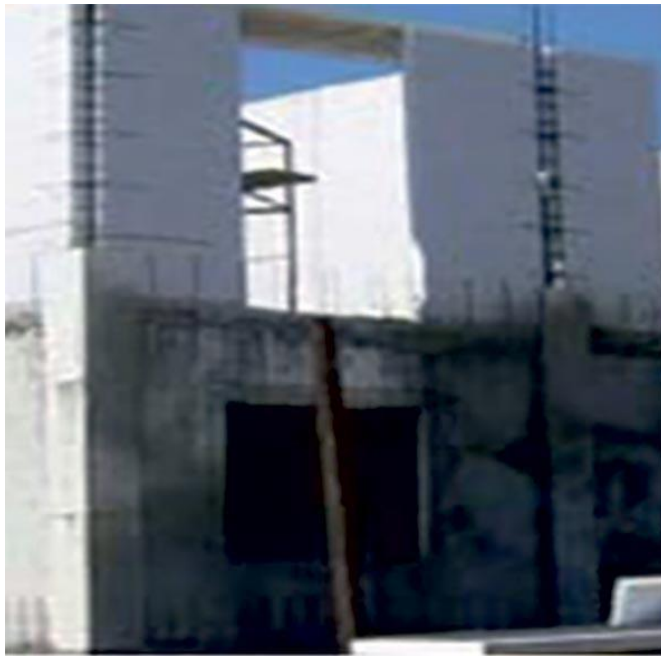
Figure6:ExpandedPolystyrene(EPS)corepanelsystem
